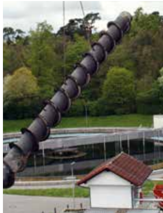
Montage der Schneckenpumpe
